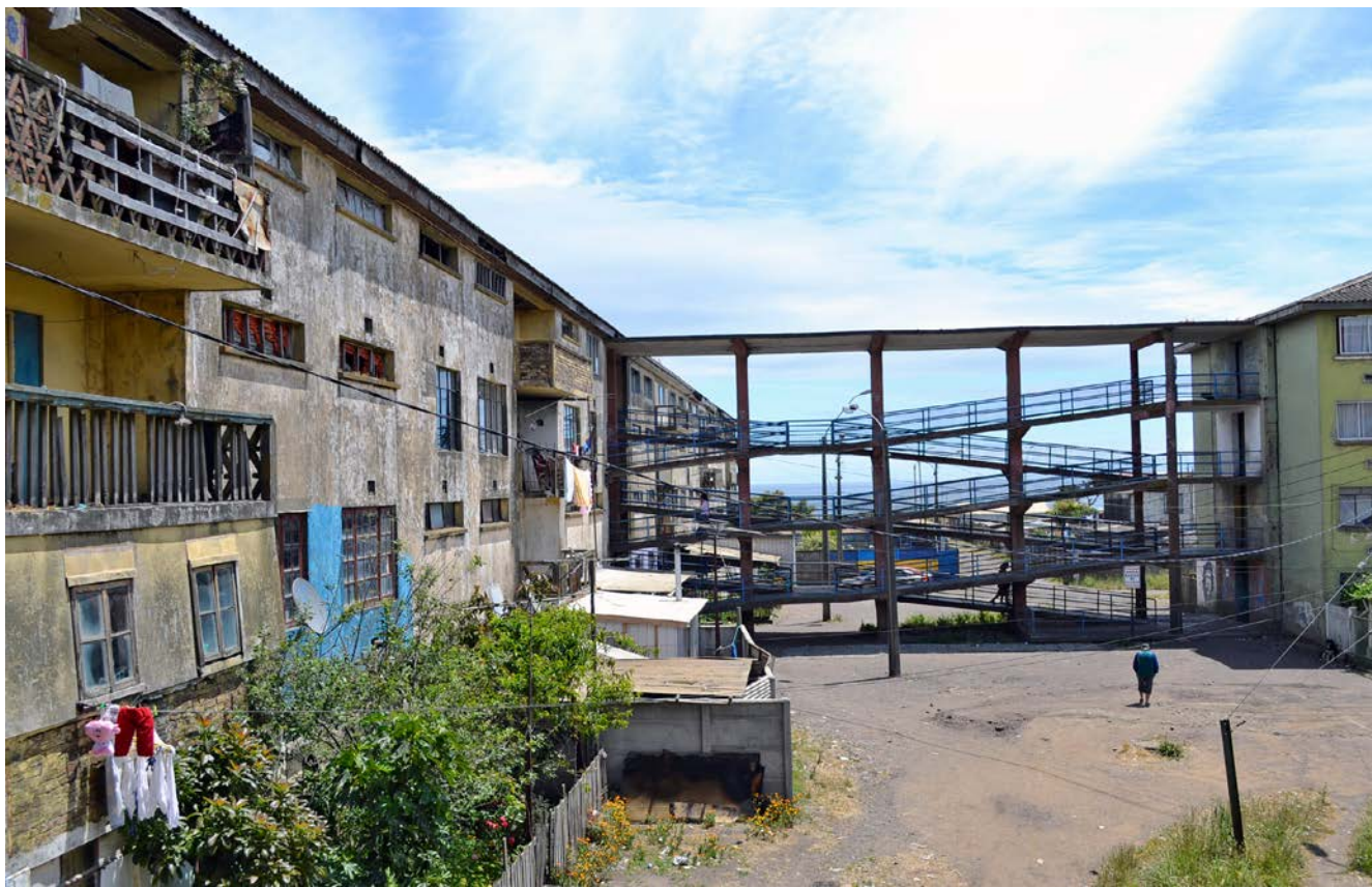
Imagen 8. Rampas del edificio Chollín (fuente: el autor).
